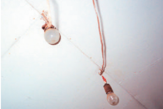
Mynd 6. Rangur frágangur lampa og lagna. Mynd 7. Rangur frágangur spennujöfnunar.
