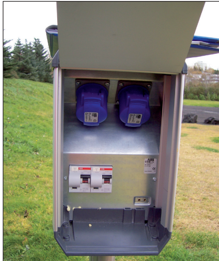
Mynd 6. Einungis má tengja hjólhýsi og húsbíla við iðnaðartengla samkvæmt staðli ÍST EN 60309-1 og 2. (CEE 17).
